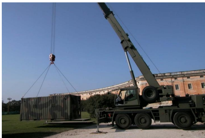
Movimentazione di shelter con autogrù e braca di sollevamento, costituita da quattro funi d'acciaio con relativi accessori.
