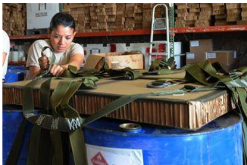
Fusti di carburante su airdrop pallet A-22 in fase di approntamento e di caricamento su velivolo C-17.
