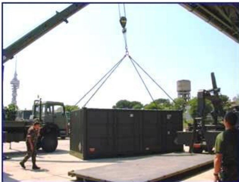
Sistema di sollevamento shelter e container con tirante in poliestere a quattro bracci.
